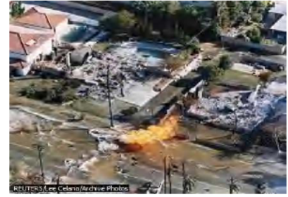
خسائر مادية (حريق, انهيار المنازل, تسرب المياه).
